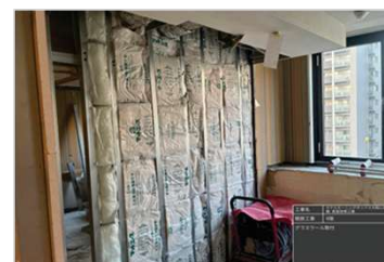
客室の防音工事
