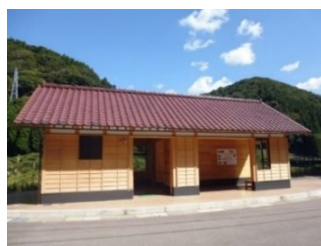
休憩所兼トイレの整備
