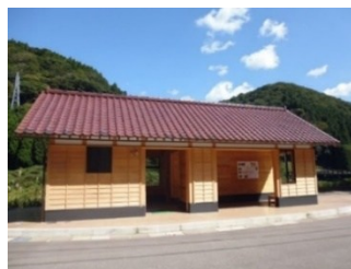
休憩所兼トイレの整備
