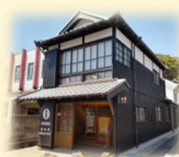
<佐賀県 嬉野市塩田津> 公開活用施設
