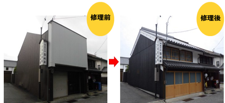
たつの市龍野町伝統的建造物群保存地区の修理事例
