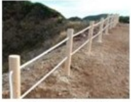
(ロープ柵の整備)
