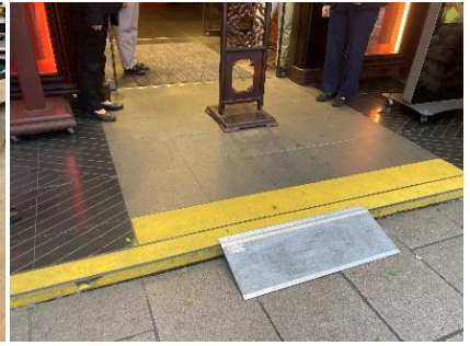
■ 車いすユーザー来店時に出す簡易スロープ
