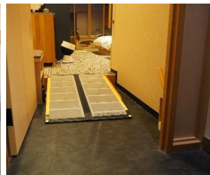
■ 入口に簡易スロープを設置
