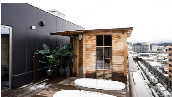
屋上の休憩室を飛騨高山の雄大な夜空を見ながら入浴できるジャグジー＆サウナに改修。
