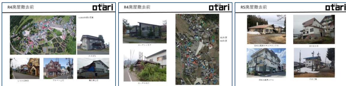
R4年度、R5年度に行われた廃屋撤去の事例（資料・写真提供：小谷村）
