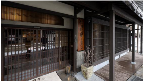
日本の様式・風情ある町並みを次世代に継承するため、景観維持のための補修工事を実施。
