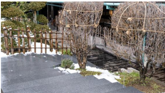
滑りやすい板敷の階段を石段に改修。
