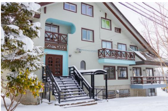
景観に配慮し、リゾート地に適した色合いの外壁改修。
