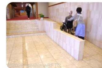
フロントから売店・エレベーター方面への、6段の階段とスロープ（傾斜約7度、1/8）。
