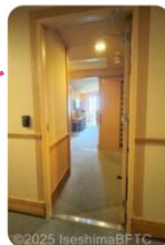
客室入口幅76センチ、片開きドア。段差なし。
