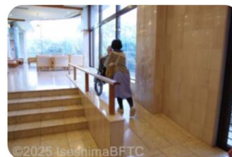
入口からフロント・ロビーへの、4段の階段とスロープ。スロープは、やや傾斜がきつい（傾斜約8度、1/7.5）ので注意。
