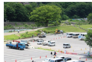
せせらぎ公園駐車場の舗装更新
