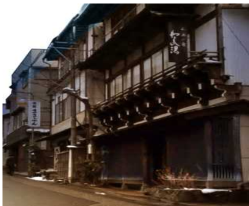
老朽化した施設
