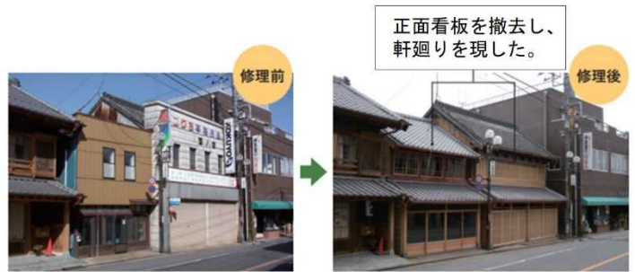
香取市佐原伝統的建造物群保存地区の修理事例
