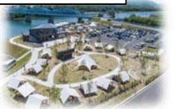
河川敷広場への新たな賑わい拠点の整備(木曾川/美濃加茂市)
