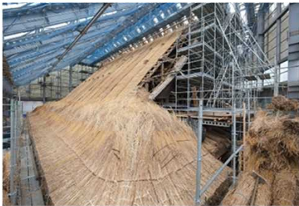
重要文化財 天徳寺本堂ほか2棟 半解体修理の様子（秋田県）
