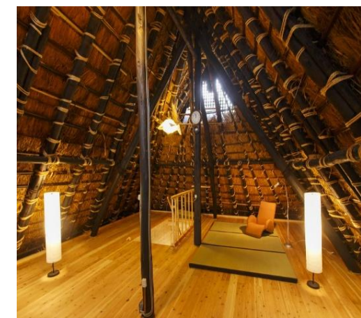
かやぶき屋根の屋根裏
