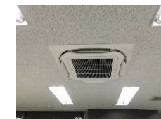
換気設備の導入
