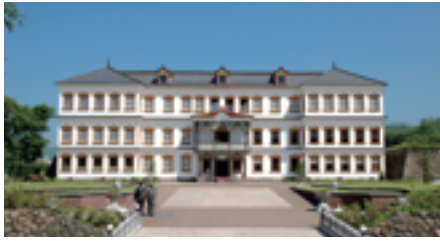
小坂鉱山事務所(重要文化財)
