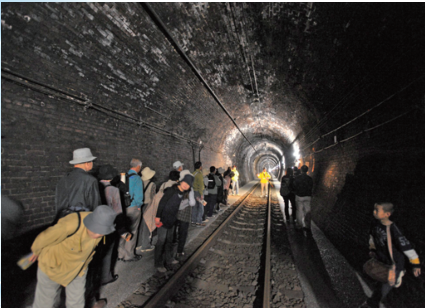
廃線トンネルを利用した遊歩道
