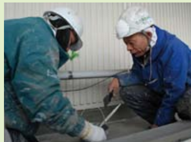
近くの高等学校の外壁を塗装している様子。作業中は活気があり、和やかな雰囲気。
