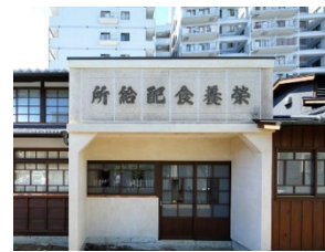
旧栄養食配給所(外観)
