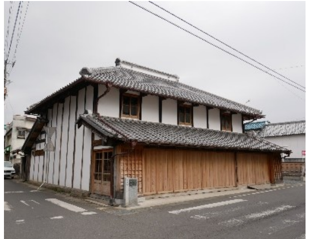
復旧した高久家住宅
