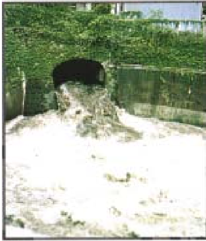
（雨天時の未処理下水放流状況）
