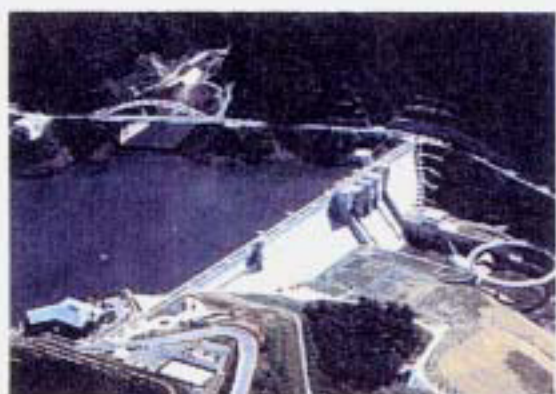
上下流交流のために開かれた堤体と広場 (日吉ダム、水資源開発公団)
