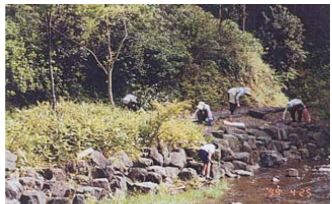
砂防施設内での清掃作業
