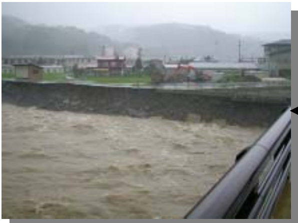
長良川の法面崩壊(岐阜県白鳥町)
