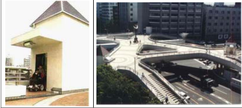
立体横断施設に設置されたエレベーター
