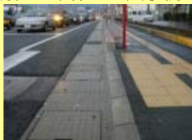
視覚障害者誘導用ブロックを設置した例
