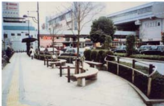
乗合自動車停留所や歩行空間を有効に活用した休憩施設の例
