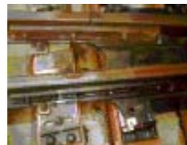
例) 分岐器と一般区間のレールの高剛性接着継手
