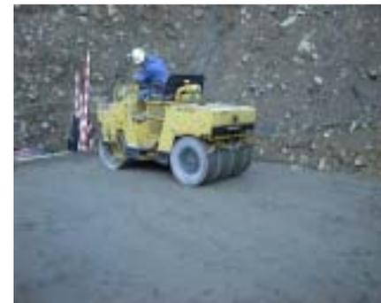
砂防ソイルセメント締め固め状況
