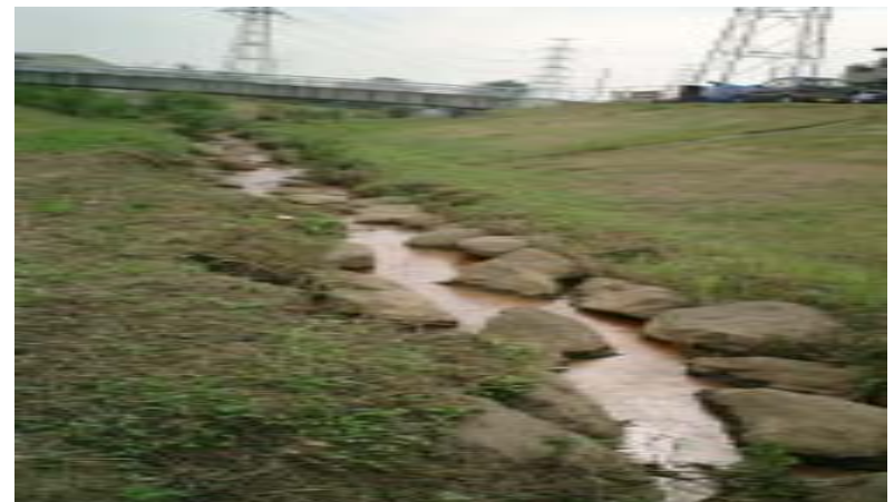
枯渇が進む生実川へ維持用水として処理水を導水
