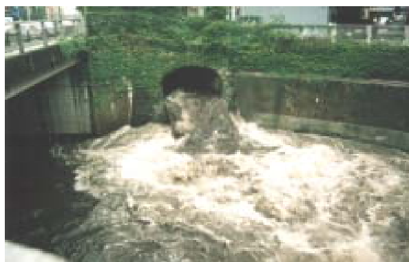
雨水の影響が大きいときの吐口の様子
