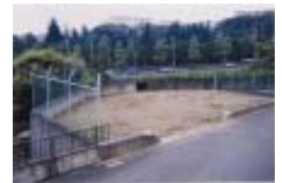
埋め立て後の状況
