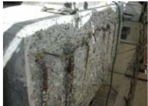
「ASR 橋脚の維持管理に関する検討委員会」(委員長：宮川豊章 京都大学大学院教授)において、耐荷力上は重要度の低い部位であり緊急性を要するものではないと判断された。破断箇所は溶接により鉄筋量を回復し、安全な状態にある。
