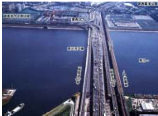
国道357号荒川河口橋
