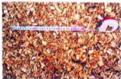
ウッドチップ舗装(施工後)
