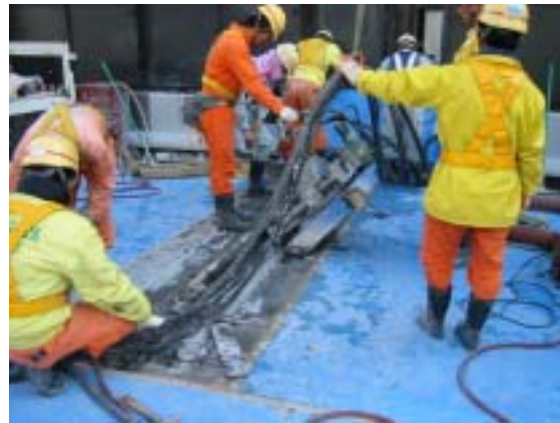
〔カット・ジャッキ工法〕
