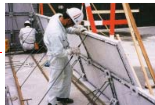
残存型枠施工状況写真
