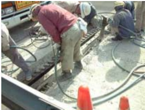
〔コンクリートブレーカー〕 従来工法
