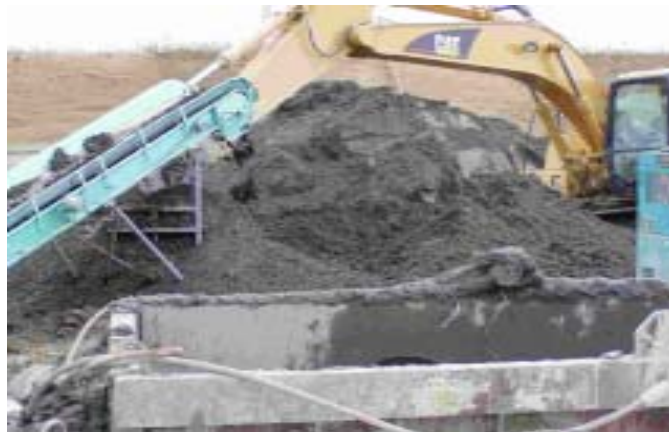
オデッサシステムによる改良土
