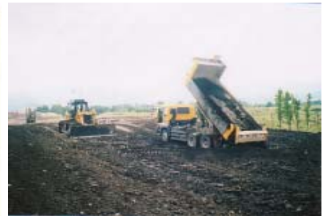
高速道路への盛土利用
