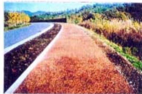
ウッドチップ舗装(施工後)
