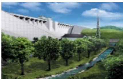
《魚のみち整備》
