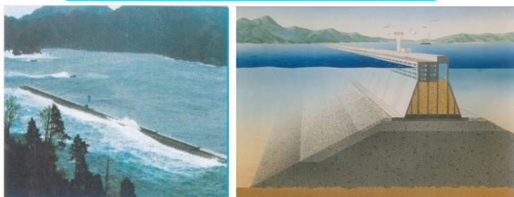
釜石港 湾口防波堤
