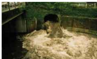
図1-8 雨天時における神田川の未処理下水の放流状況
