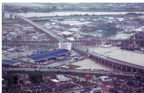
H10.8.4 新潟・下越集中豪雨災害 (北陸自動車道新潟西IC付近)
