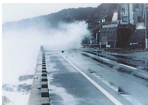
海岸侵食(石川県七尾市)
