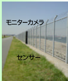
センサー・モニターカメラの設置
