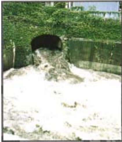
（雨天時の未処理下水放流状況）
