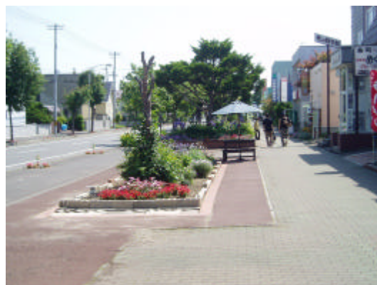
都市計画道路（南島松 1 号通）の計画幅員 16 m より更に広く、歩道と花壇用地 8 m を確保した箇所。沿線の恵み野商店会や「花の千人植え」で管理している。
