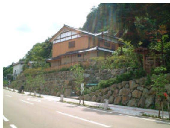
改築後も石積みを施し、景観に配慮してある。
