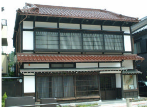
曳き家により町屋を再生し、通りの拠点施設として活用している。
