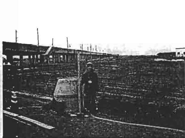
新幹線の橋脚付近の下水道マンホールが液状化により浮き上がっている。
