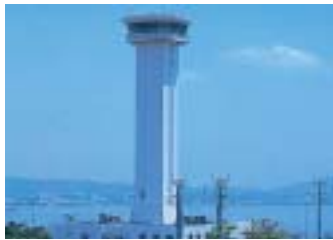
管制塔耐震化などにより既存空港の安全を確保します。
