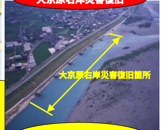
大京原右岸災害復旧
