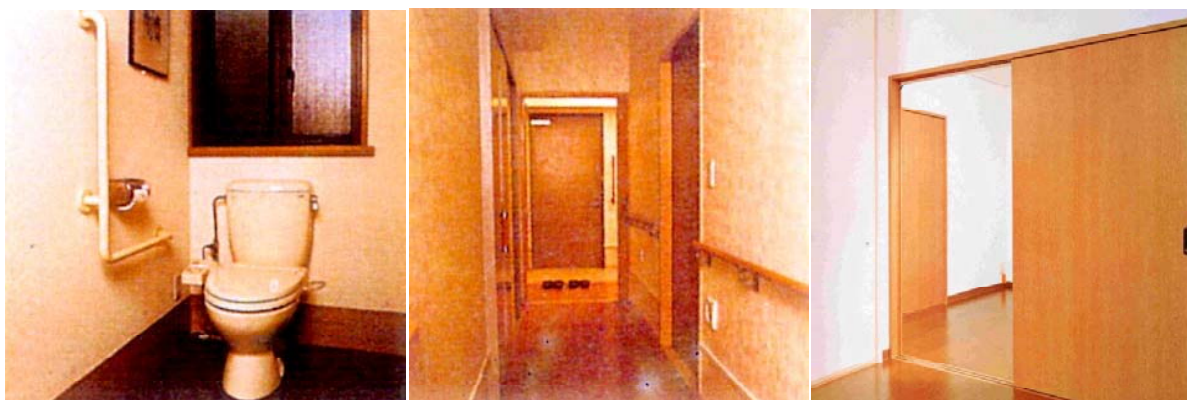
手すりの設置
