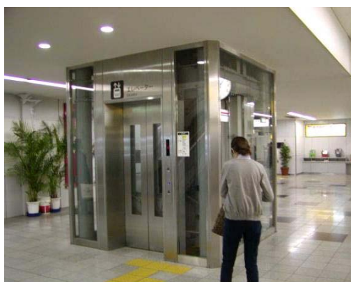
エレベーターの設置
