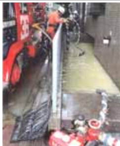
地下施設浸水による死亡事故 H11年6月 福岡市
