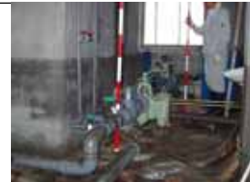
ポンプ場の浸水被害 (H16.8香川県土庄町)
