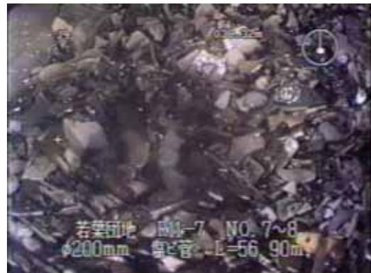
写真 4.2.3 ディスポーザー設置地区の管渠内堆積物の状況 (歌登町)<sup>11)</sup>
