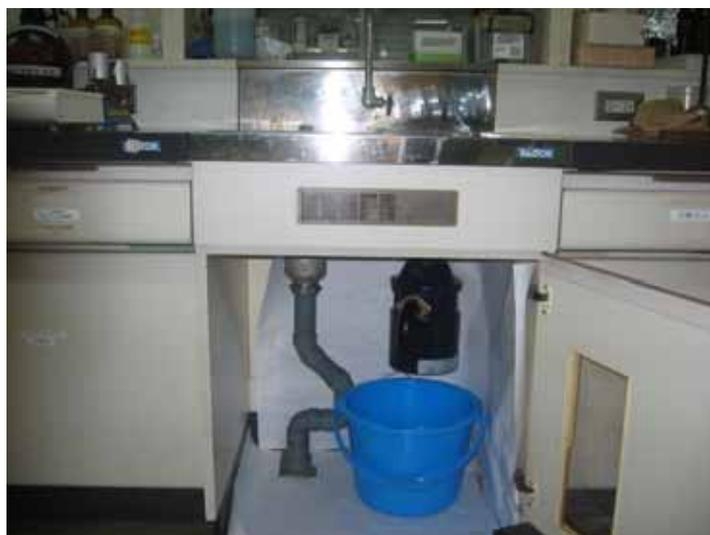
写真 3.2.1 厨芥の水質転換率調査の状況（ディスポーザーの設置状況）<sup>8)</sup>
