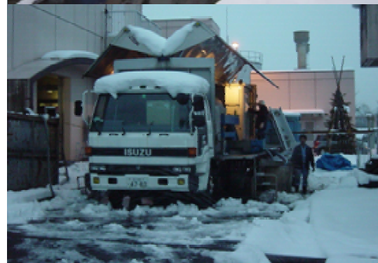
移動式脱水車による汚泥処理
