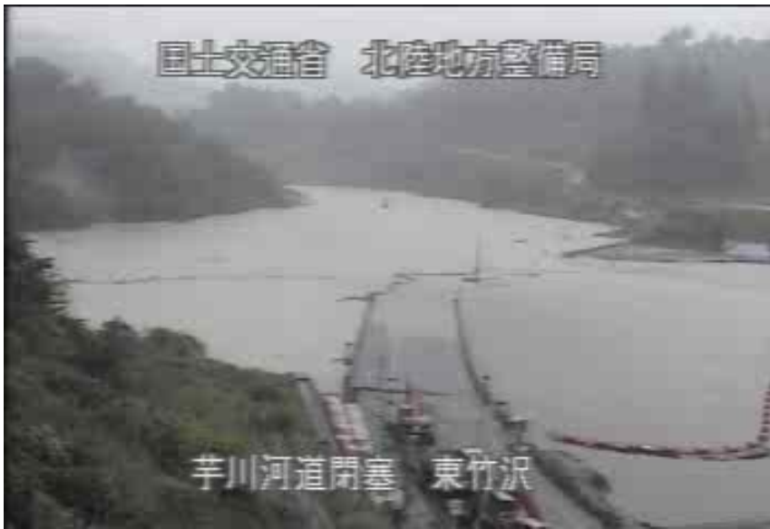
東竹沢地区 水位状況
