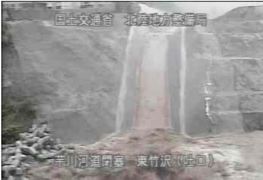
東竹沢地区 仮排水路の状況
