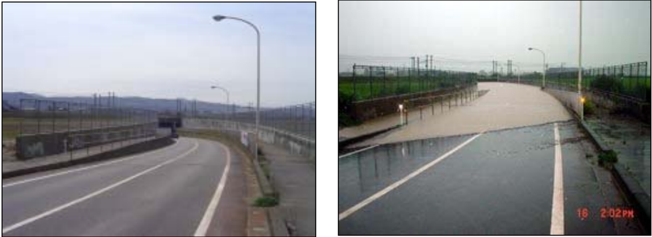
図 6 平成 16 年 7 月 新潟県三条市アンダーパスの浸水状況（左 平常時、右 浸水時） （出典：国土交通省 国土地理院ホームページ）
