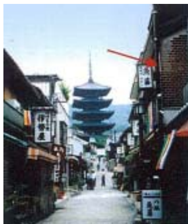
写真 軒下配線
