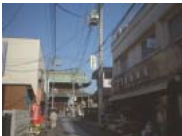
安全・景観阻害の電柱、電線
