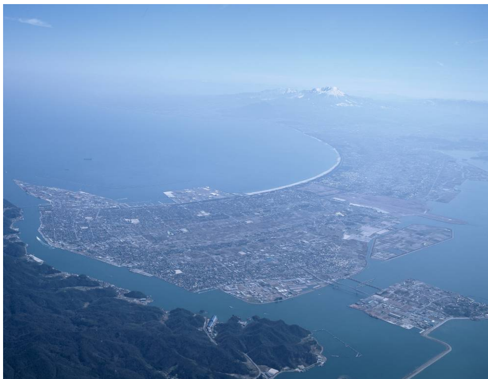
境港現況写真
