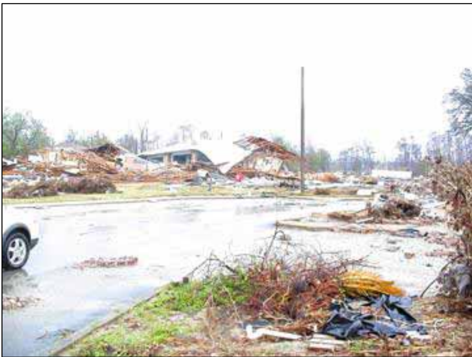
写真 2 海岸近くの民家の破壊（ロングビーチ付近：上陸地点より約40km東） 東に行くほど潮位が高く、木造の第一線の建物はほとんど破壊され、かなり奥の民家まで破壊は及んでいる。 こうした被害は、スリランカやタイでの津波による海岸近くの建物の壊滅的被害を思い出させるものであり、水による力の大きさを考えさせるものである。
