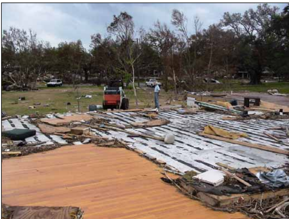
写真 - 1 海岸近くの民家の破壊（パスカゴウラ：上陸地点より約100km東） 海岸の第一線に建つ民家が破壊され全く無くなっている。 第一線背後の民家は破壊を免れているが浸水している。
