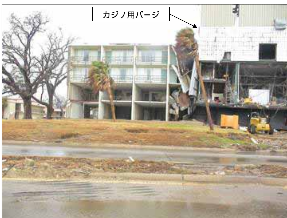
写真 4 海岸に係留されていたカジノ用バージが陸に押し上げられ建物を破壊している（ペロキシ：上陸地点より約70 km東）。下図は上図のカジノ用バージを海側より撮ったものである。建物とカジノ用バージがぶつかっている。
