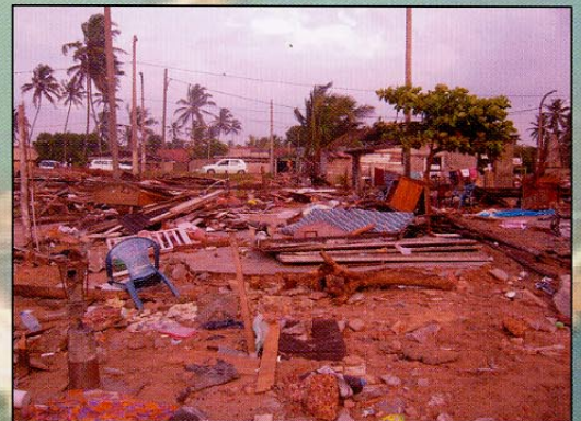
インド洋大津波における沿岸住居の被害 (スリランカ モラトワ市)
