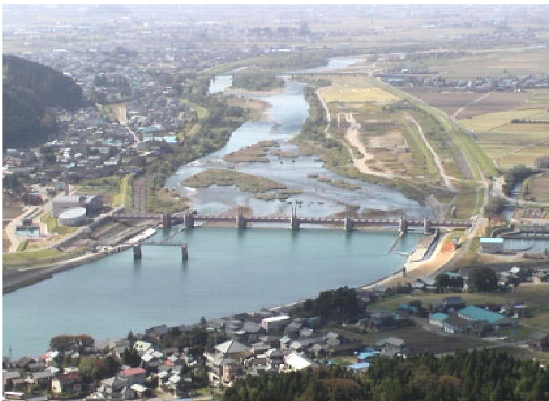
完成後の鳴鹿大堰付近の眺望
