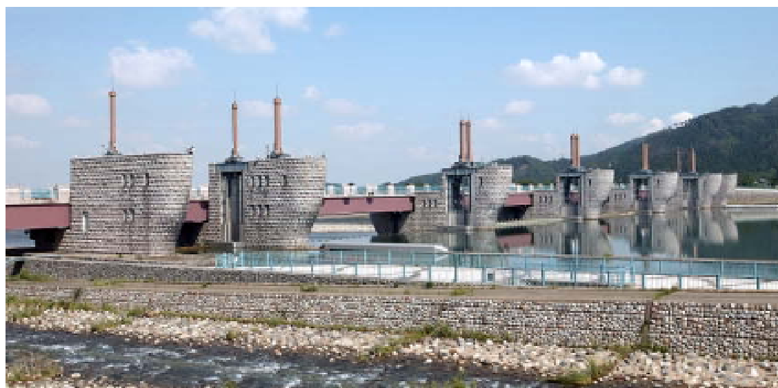
完成後の堰上流左岸からの眺望
