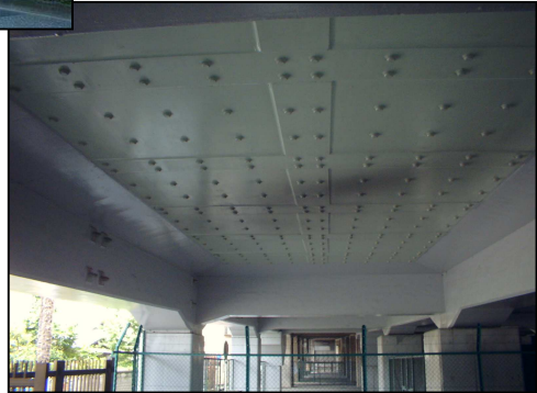
現行技術鋼板接着後
